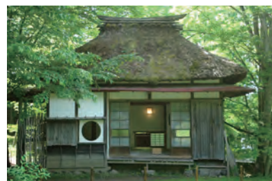
野上弥生子北軽井沢山荘の離れ (当館敷地内に1996年移築、2017年7月、茅葺き屋根の葺き替え工事後、リニューアルオープン。写真は改修前)
